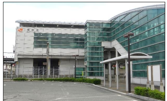
駅舎改装後20年、舞坂駅（北口）
